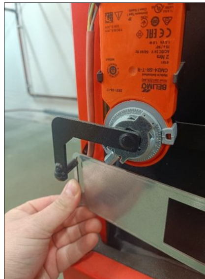
Enlever la tôle des volets d'air du moteur
