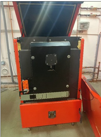
Démonter la façade avant
